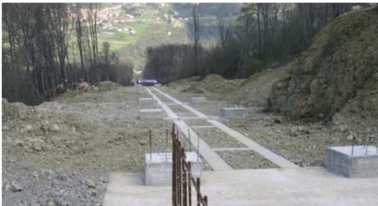
Pol kilometra trase cevovoda je pripravljene za namestitvev cevi.
