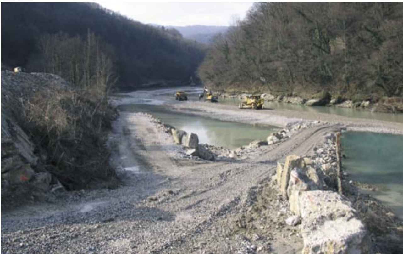
Praznjenje jezua Ajba so izrabili za gradnjo zaščitne pregrade za ČHE Avče.
