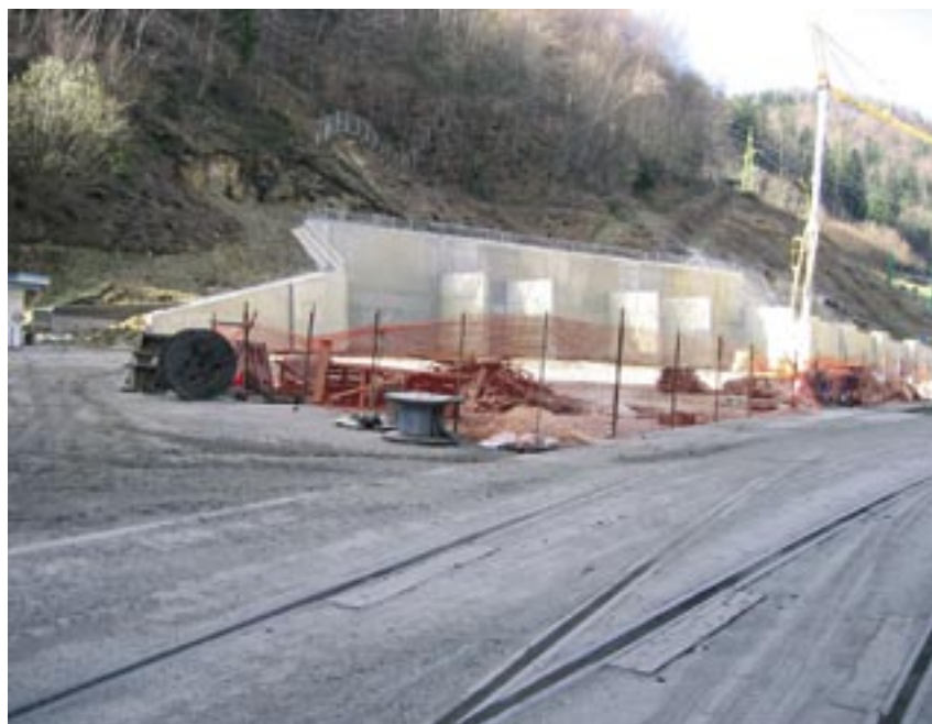
Podporni zid za pripravo potrebnega prostora za postavitev plinskih turbin.
