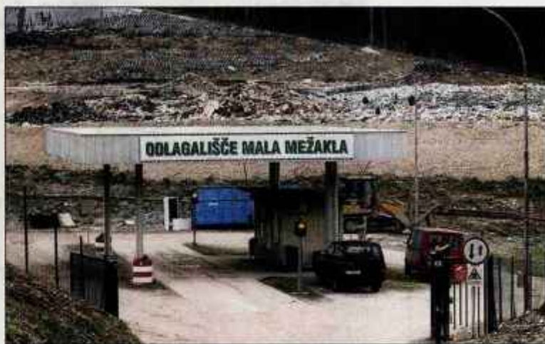
Deponija Mala Mežakla je ena najbolj urejenih pri nas, na njej naj bi uredili še sortirnico in center za obdelavo odpadkov. / Foto: Anka Bulovec
