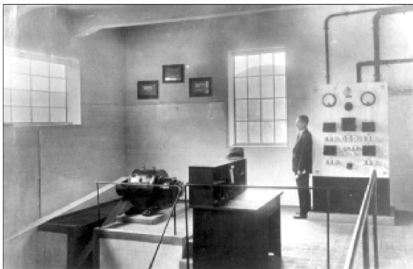
Elektrarna veleposestva Marijingrad v Nazarjah na dan otvoritve 1. maja 1930. Na sliki je tedanji vodja elektrarne Franc Hren.
