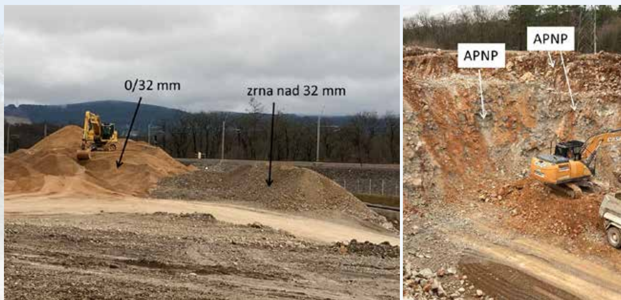
Slika 1: Pregledi deponij izkopanega materiala iz predorov in predkopa na divaški strani. APNP pomeni apnenec slabše kakovosti, ki ni uporaben za vgradnjo v beton, je pa uporaben v druge namene (vir: arhiv ZAG).
