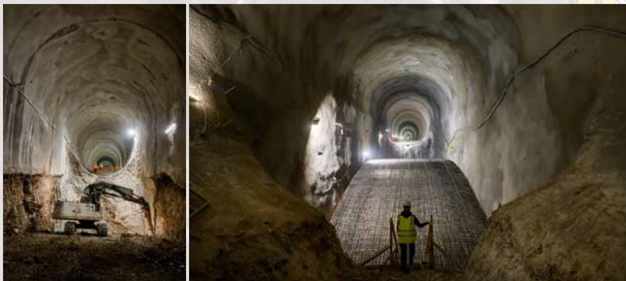
Slika 5: Izkop za temelj in armatura ločne konstrukcije
