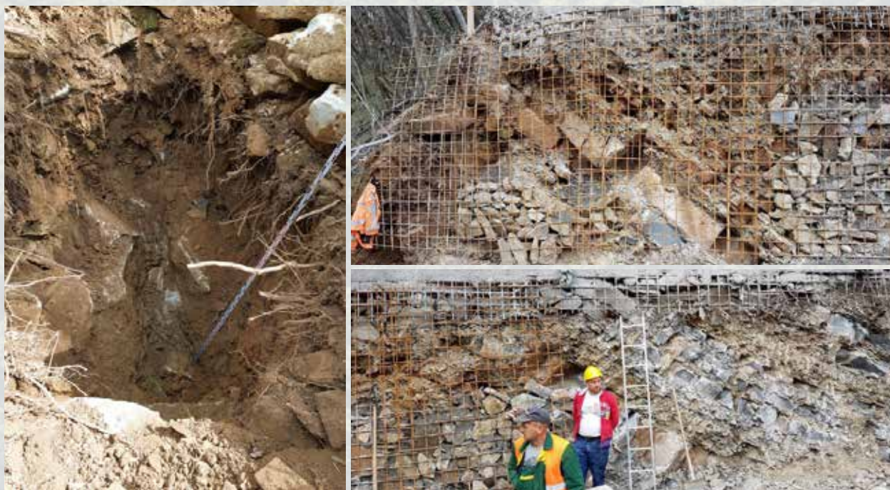
Slika 2: Levo: razkop na območju dostopne ceste T1b2 pri PZ1; desno: zgradba tal na portalnem območju glavne cevi
