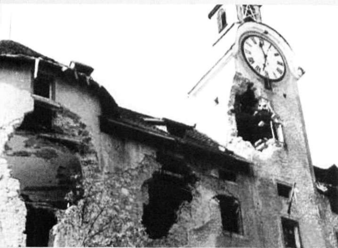
Deloma poškodovan idrijski grad. Poškodbe so nastale zaradi zavezniškega bombardiranja mesta.
