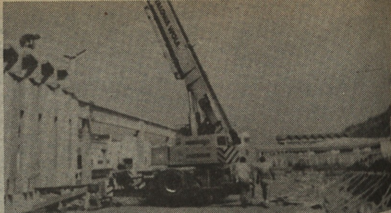
V Ivanjici je bila montaža opravljena v 18 dneh
