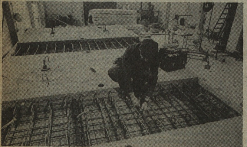
Postavitev mernega lističa na kable
