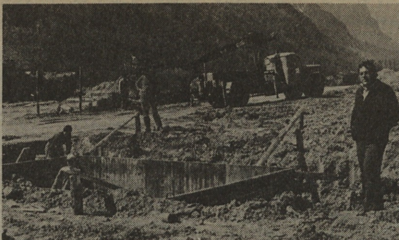
Opaženje enega izmed temeljev na platoju za glavno halo v izmeri 190 krat 120 metrov. Hala bo imela skupno 58 glavnih temeljev, vsak izmed njih pa zaseda 24 kvadratnih metrov površine. Konstrukcija bo jeklena. Desno na sliki je pomočnik vodje sektorja gradbeni tehnik Marjan Zupan. Vodja sektorja je gradbeni inž. Miha Benedik
