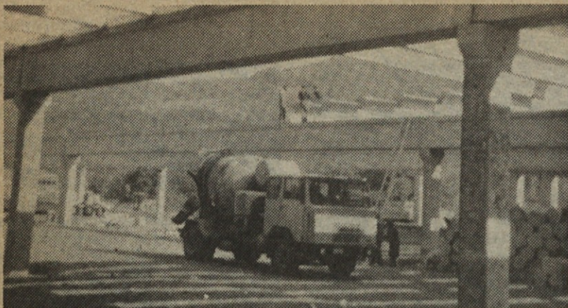
Po železnici je bilo v Ivanjico prepeljanih okrog 2.500 ton armiranobetonskih montažnih elementov
