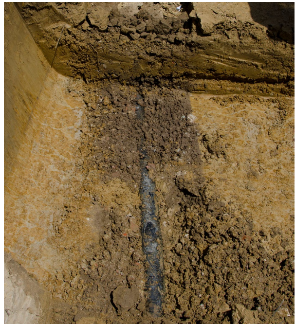
Vzhodni krak vodovoda z vodovodno cevjo, SE 102/SE 92 (foto J. Hobič).
