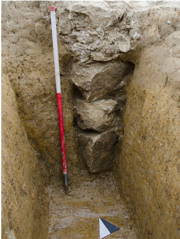
Slika 23 Kanal vodnega zbiralnika, ki se naslanja na podpornik 3 (SE 377/SE 378) (foto J. Hobič).
