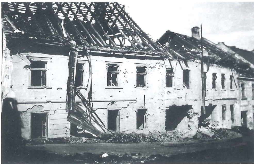
18. Razrušeni hotel Koklič na Ljubljanski cesti nasproti Seidlove hiše, na skrajni desni del Murnove hiše, v kateri so stanovali Knollovi
