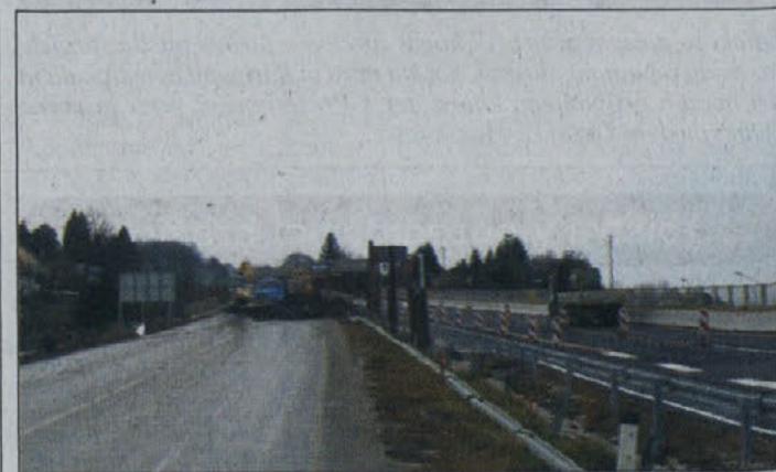
Levo stara hitra cesta, kjer potekajo dela, desno nov pas avtoceste in v ozadju ukop na Čatežu ob Savi.
