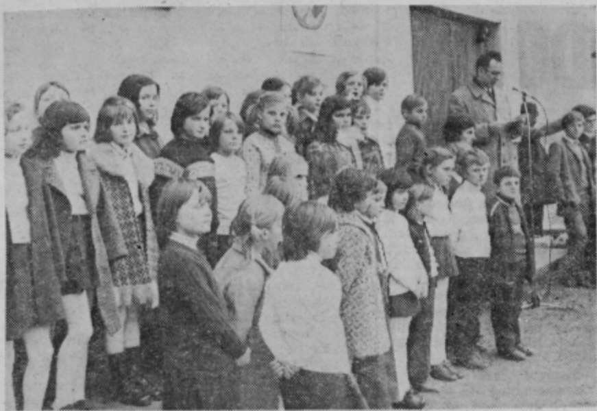
Krajevni praznik in 30-letnico pohoda Štirinajste divizije na Štajersko so na Dobrni počastili tudi z graditvijo temeljnega kamna za novo telovadnico pri osnovni šoli. Pod streho bo do praznika celjske občine, 20. julija, povsem nared pa do začetka novega šolskega leta. Otroci so ta dogodek počastili s pevsкими, recitacijskimi in telovadnimi točkami. Na posnetku skupina nastopajočih med govorom ravnatelja osnovne šole »Štirinajste divizije« Cirila Marinčeka. Foto: MB
