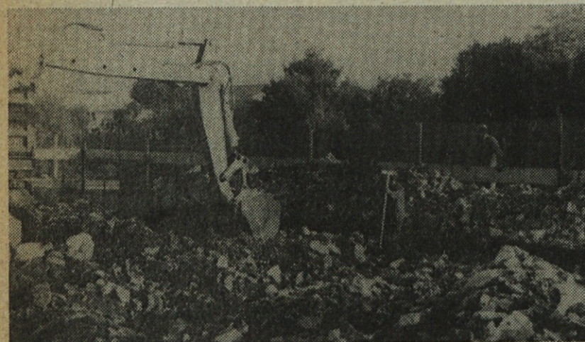
Izkop kanalov za pasovne temelje
