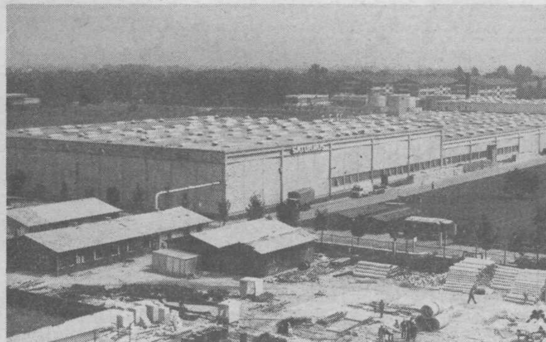
POGLED Z VRHA JULONA — del industrijske cone MP — 3
