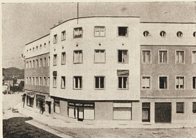
SL. 79. STAVBA V MARIBORU.
