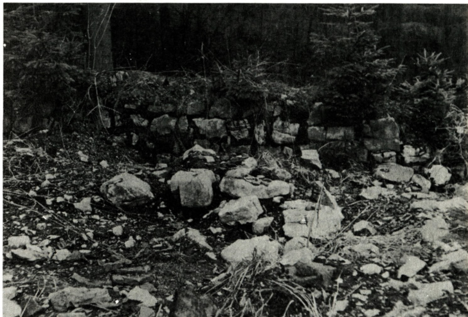
Ostanki obzidja poznoantične trdnjave na Brstu nad Martinj hribom. Fotografija zidu iz leta 1981. Danes je zid v večji meri uničen. (foto: M. Frelih)
