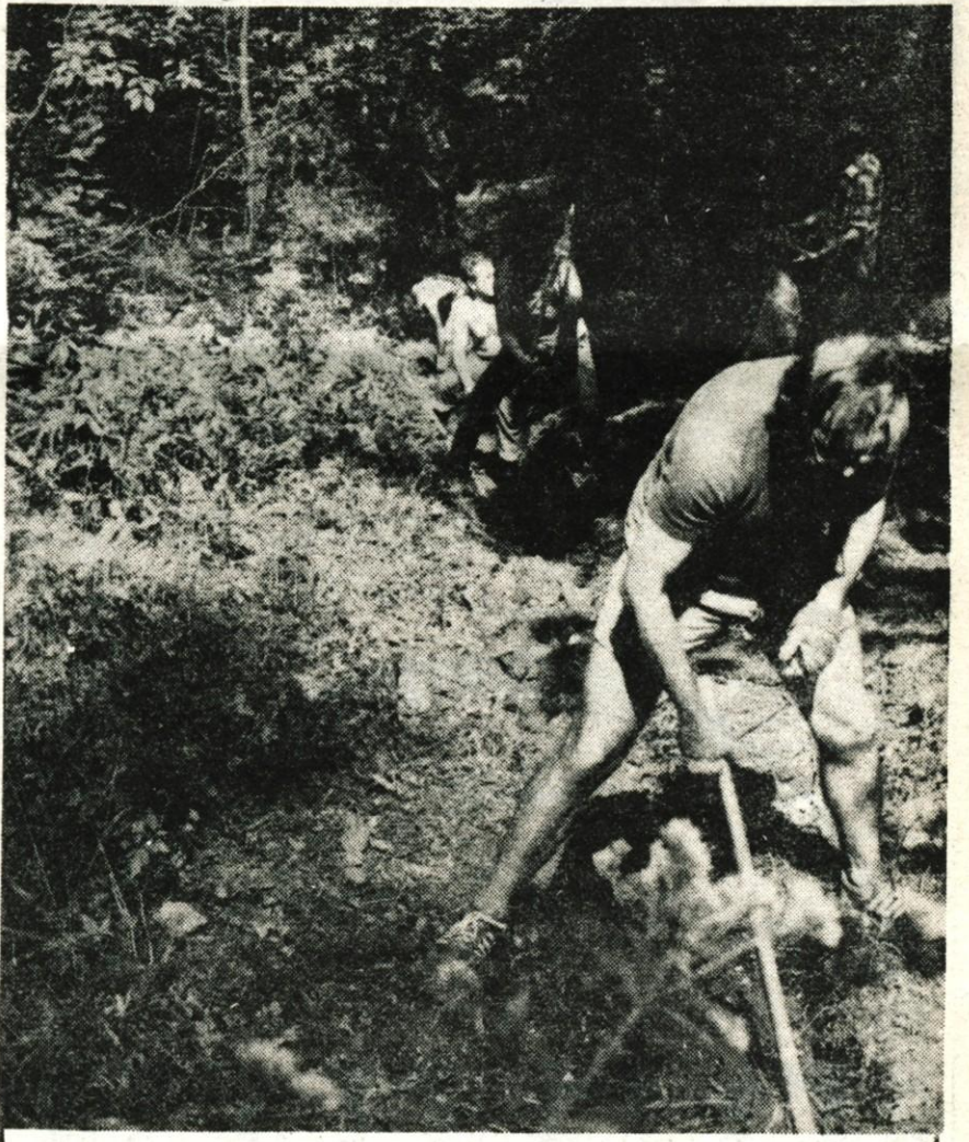
Vodovod na Golem brdu - Na Golem brdu teče obsežna akcija izgradnje vodovoda. Po projektu STC, tozda Nizke gradnje, bodo uredili zajetje iz Ovcakovega studenca, napeljali 2.100 metrov primarnega omrežja, zabetonirali so že rezervoar za 50 kubičnih metrov vode. Bodoči porabniki vode sami financirajo izgradnjo vodovoda, računajo pa, da bodo s prostovoljnim delom opravili dve tretjini dela, tako da jih bo skoraj 4-milijunska investicija veljala le tretjino. Voda bo v približno sto hiš pritekla še letos. Omeniti pa velja, da bodo poleg pitne vode vaščani bogatejši tudi za požarni bazen, kar bo v mnogočem izboljšalo požarno varnost. -fr
