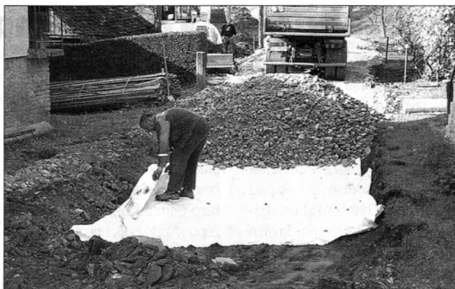
Dela na zahtevnejšem odseku ceste Kropa-Otok (foto: Marija Lebar)
