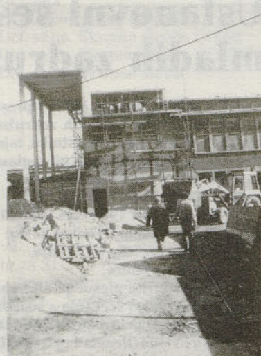
CMI pred dokončano rekonstrukcijo
