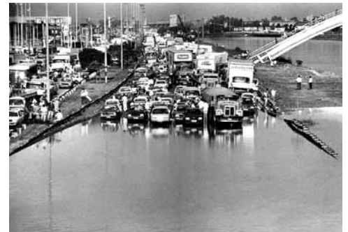
Poplava na eni od strateških točk proizvodnje: glavna prometnica, ki povezuje vzhod in zahod mesta. Flooding of the strategic point of the production: the main highway that links east to west
