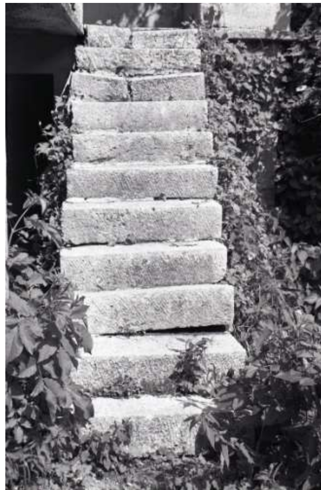
Rijan kaman – poševno brazdanje, tipična obdelava pietre piasentine . Levo vogelniki hiše v Mašeri, desno stopnišče v Matajurju.
