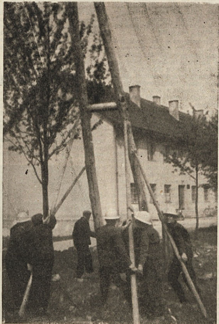
Delavci, ki postavljajo električne droge, imajo zaščitne čelade
