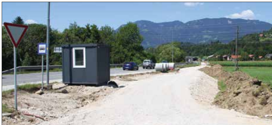
Zaradi bližine regionalne ceste je v času gradnje kolesarske steze potrebna večja previdnost udeležencev v prometu. (Foto: Benjamin Kanjir)
