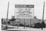
Inicio de obras de iluminación en la Villa Eslovena (Lanús, Pcia. de Bs. As.).
