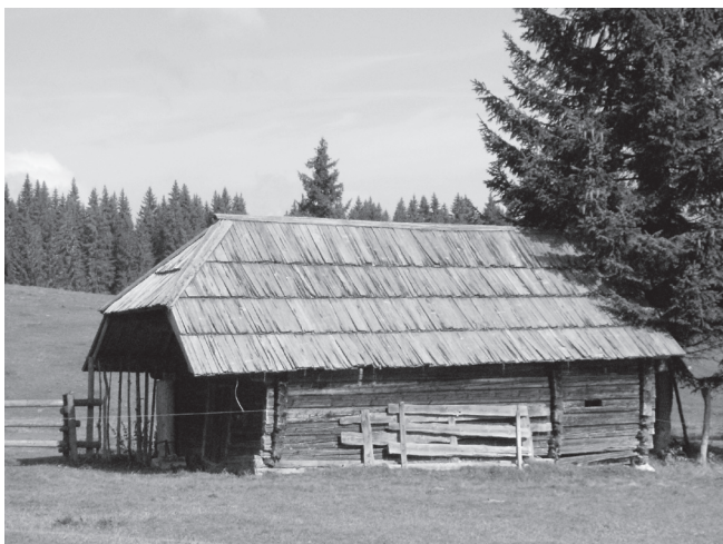
Knofelnov stan pred obnovo.
