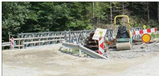
Promet v Podvolovlju v času prenove poteka preko montažnega mostu. (Foto: Marija Lebar)
