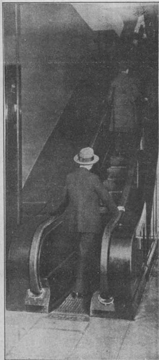
Prve vlačilne stopnice v Nemčiji (Rolltreppe) so postavili v nekem berlinskem blagovnem magazinu; vstopi se na stopnico in poseben mehanizem sam dviguje človeka od stopnice do stopnice
