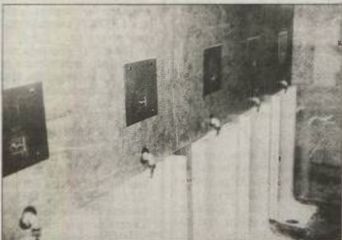
Umivalniki in splakovalniki na senzorne varčujejo z vodo.
