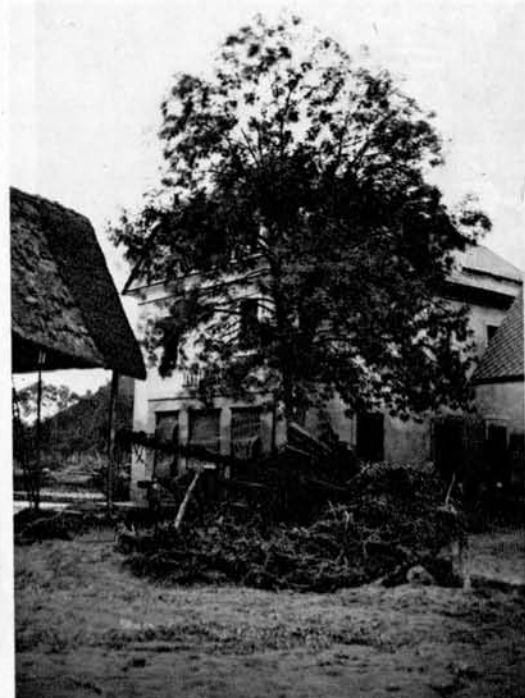
Dolarjeva trgovina v Poljanah, pri kateri je stopila voda skoro do prvega nadstropja.
