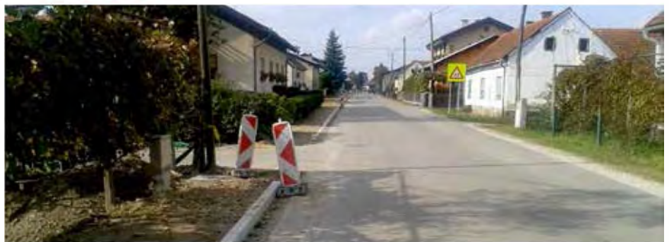
Gradnja hodnikov za pešce na Melincih
