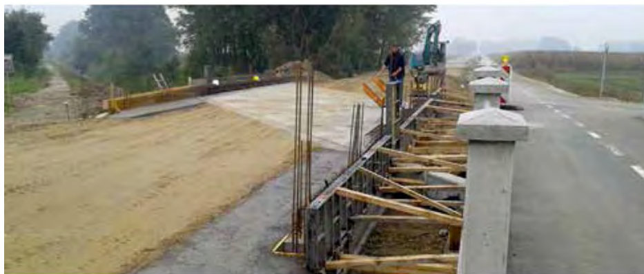
Rekonstrukcija mostu čez potok Dobel v Beltincih
