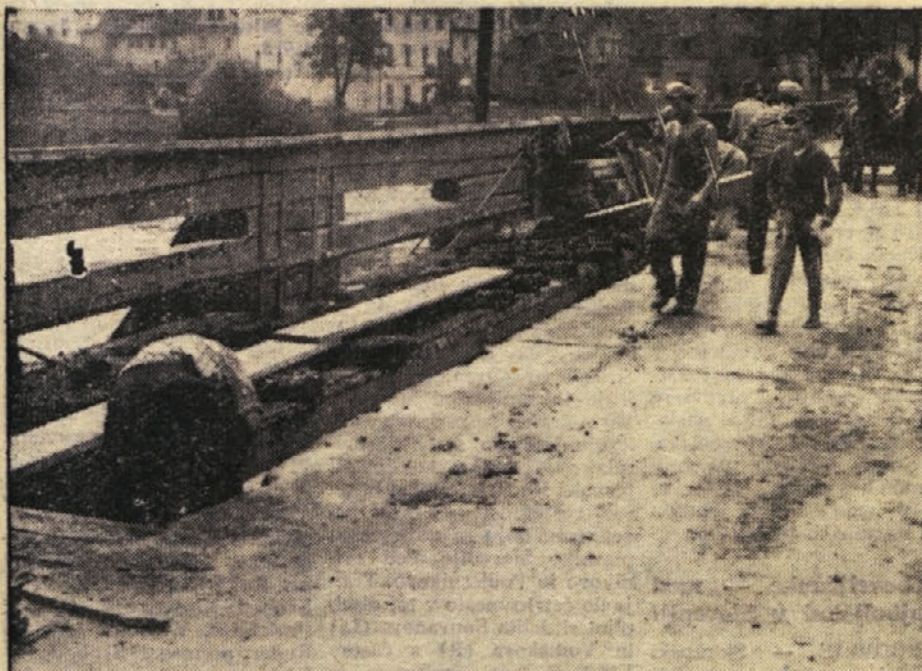
OPRAVILO LITIJSKEGA MOSTU je bilo že nadvse potrebno. To lahko opazijo vsi, ki predo v teh dneh — ko so začeli s popravilom — čez most
