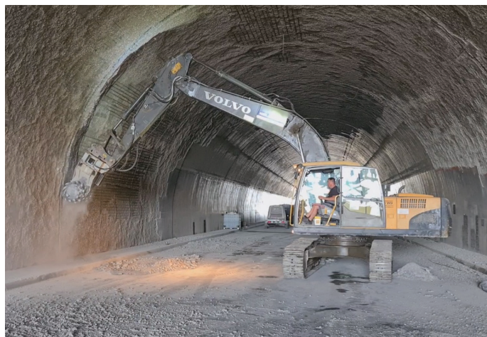
Slika 8. Lokalno poglobljanje površine z bradavičastim rezkarjem za vgradnjo mrež, 13. 7. 2023 (foto: Ponting, d. o. o.).
