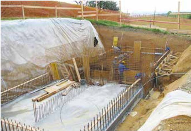
Na vrhu vzpetine, čez cesto pokopališča v Zgornjih Moravcih, delavci Pomgrada gradijo vodohram, z zmogljivostjo 150 kubičnih metrov.
