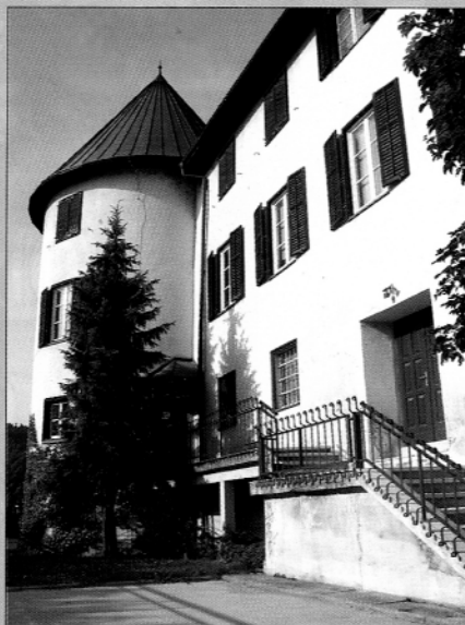
Vhod v skladišče orožja in vojaške opreme OŠTO Mozirje (foto: Igor Solar)
