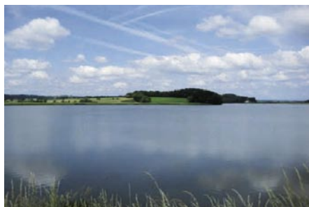
Slika 4 • Zadrževalnik Gajševci na Ščavnici
