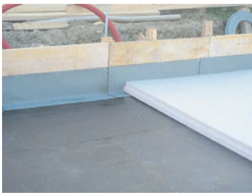
Priključek za vertikalno hidroizolacijo
