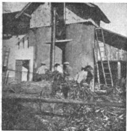
Polnjenje okroglega silosa z elevatorjem. Lastnik Titan Ignac, Črnelavci.
