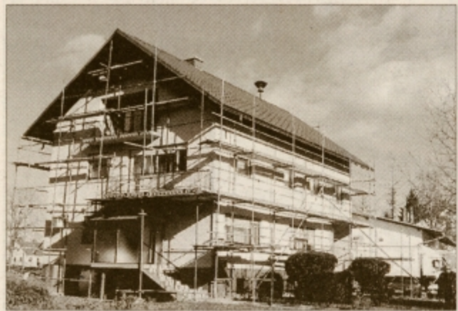
Občinsko stavbo v teh dneh prenavljajo
