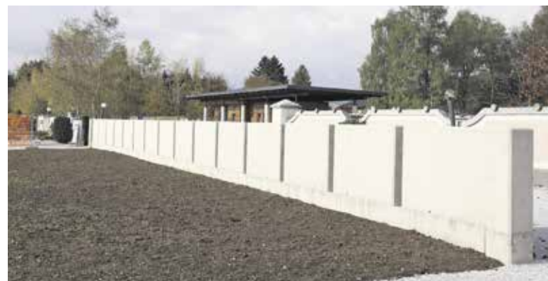
Nov oporni zid na domžalskem pokopališču
