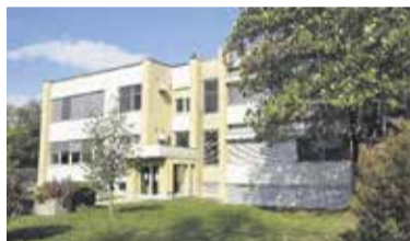
Aprila 2013 smo začeli uporabljati prostore v prizidku, ki so ga zgradili na zahodni strani šole.
