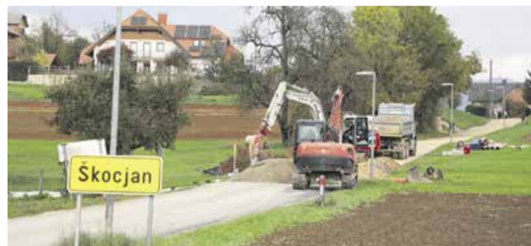
Gradnja vodovoda in kanalizacije v Škocjanu
