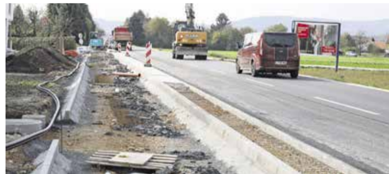
Gradnja regionalne kolesarske povezave se počasi zaključuje.
