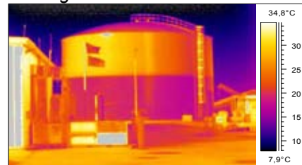
Termogram rezervoarja s tekočino
