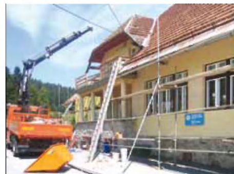
Sanacija ostrešja na stavbi enote vrta na Karlovcu
