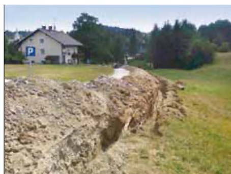
Obnova vodovoda v naselju Mala Slevica
