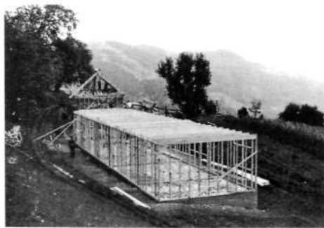
Postavitve prvega lesenega ogrodja za stanovanjski objekt Na Pečeh. Foto: M.M.
