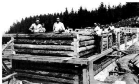
Gradnja koč iz smrekovih trostransko obtesanih brun. Arhiv: M.M.
