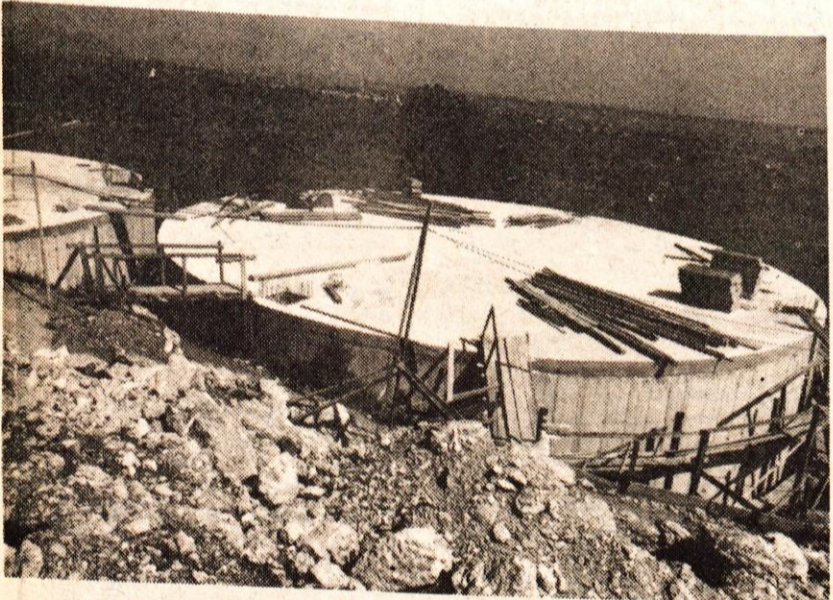
SKOFJA LOKA — Da bi bilo vode v vseh letnih časih dovolj, gradi Splošno gradbeno podjetje Tehnik iz Skofje Loke na Kamnitniku nov vodni rezervoar. Gradijo ga delavci temeljne organizacije Grandje, financira pa ga temeljna organizacija Komunala. Nov rezervoar je potreben, ker se je poraba vode v Skofji Loki v zadnjih letih močno povečala. Mesto se namreč hitro razvija, saj rastejo nova naselja na vseh koncih. — Foto: F. Pedan
