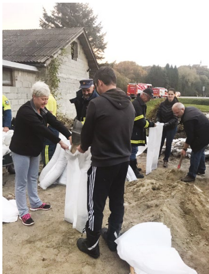
V Dolanah so s skupnimi močmi naredili 64 m dolg in 70 cm visok zid, v katerega so vgradili dobrih 16 ton mivke. Foto: Arhiv PGD
