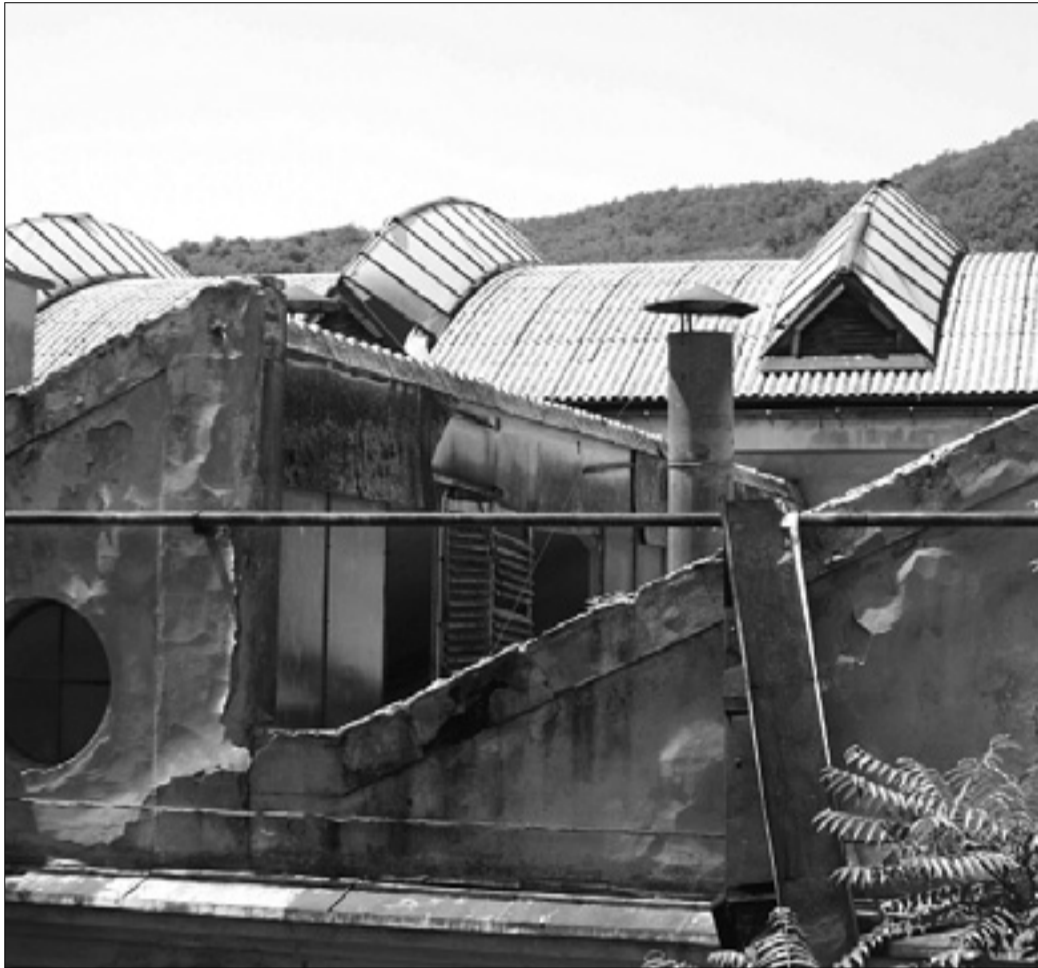
Azbestna streha bivše tekstilne tovarne
