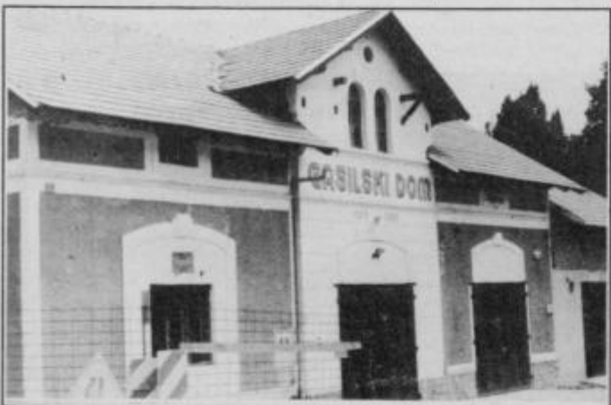
Ormoški gasilski dom med obnovo. Foto: VT
