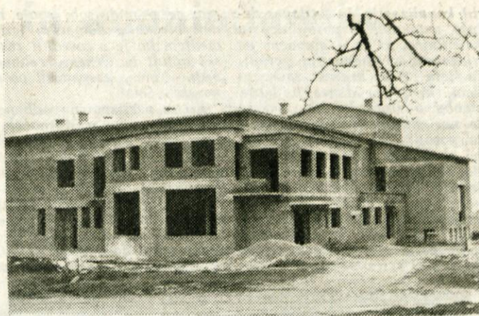
Davna želja Moravčanov — kulturni dom — se uresničuje. Stavba je v surovem stanju dograjena in pokrita
