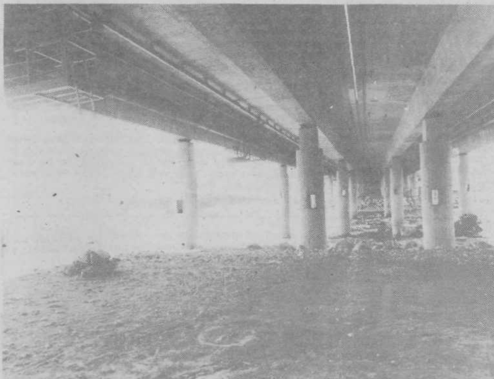
Magistralni vodovod Jarški brod-Titova cesta prečka Savo po novem mostu. Obešanje cevi na mostno konstrukcijo je bil najtežji del pri gradnji tega vodovoda.
