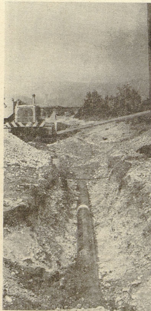
Plinovod je v zemlji in zemeljske rane se počasi celijo
