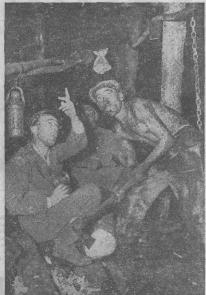
Postavljanje lesenih podpornikov v premogovniku »Kakanj«
