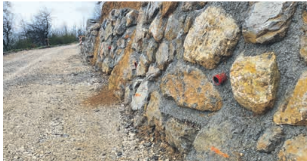
Oporni zidovi so nujni zaradi plazenja terena.
