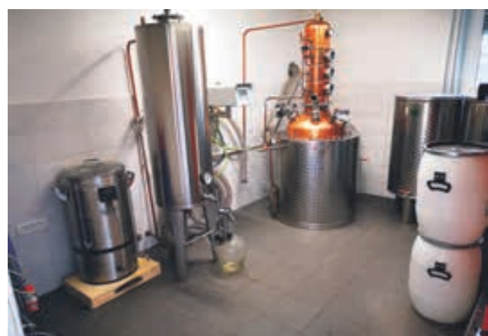
Moderni kotel za žganjekuho, voden preko računalniškega programa
