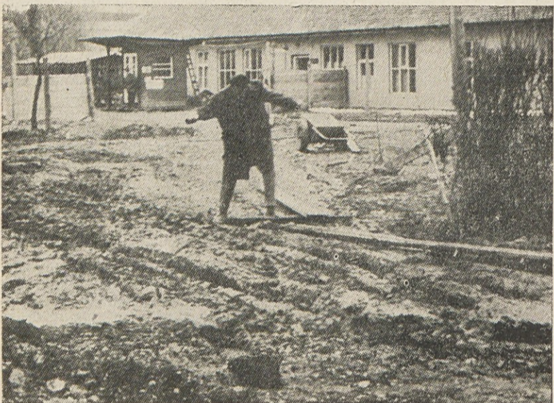
Se preden so delavci Mestne kanalizacije zgradili pri ambulanti mostiček, je bilo vsak dan videti tako podobo. Ko bo dež, se bo najbrže slika ponovila, saj pot od mosta do proge ni dovolj urejena, pa tudi ni razsvetljena
